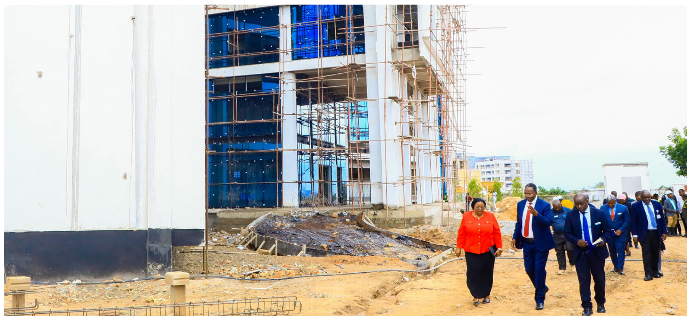
Waziri wa Nchi Ofisi ya Rais - Menejimenti ya Utumishi wa Umma na Utawala Bora Mhe. George Boniface Simbachawene akifanya ukaguzi na kuangalia maendeleo ya ujenzi wa jengo la Mamlaka ya Serikali Mtandao Jijini Dodoma.
